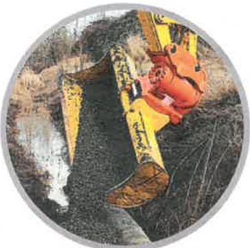
Metering Fill Material
