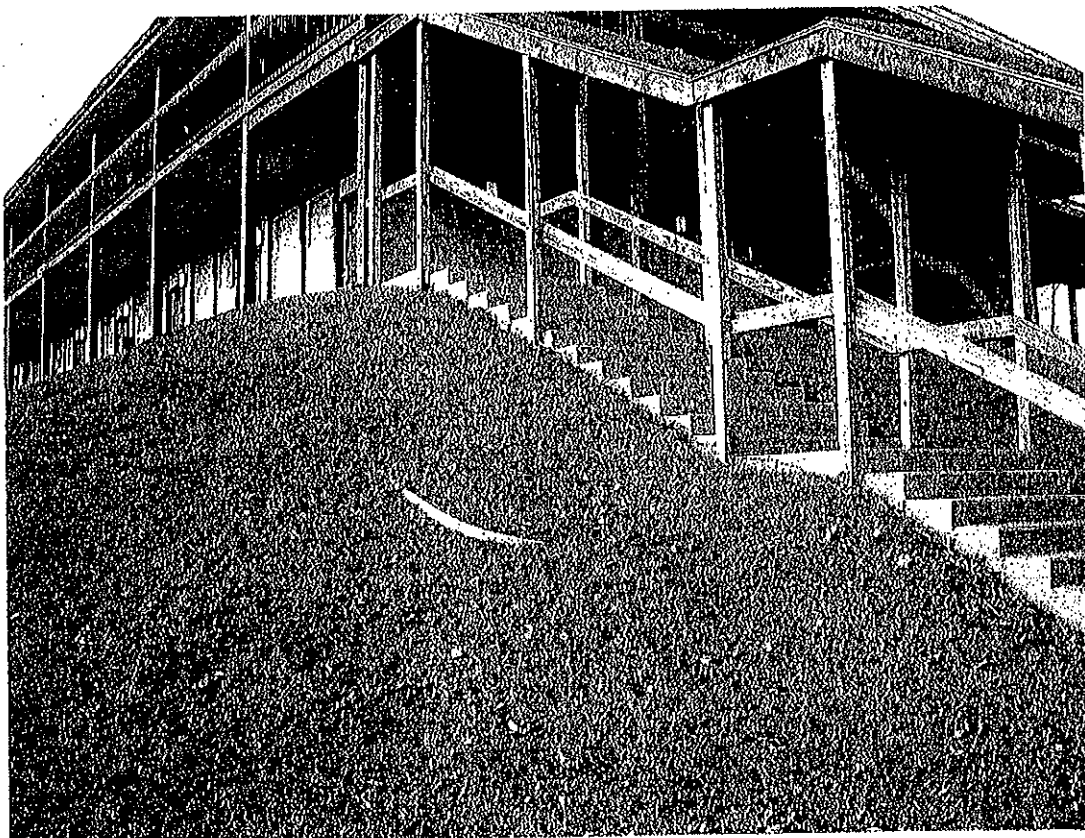
Photo 112. Exposed Gray PVC Conduit
