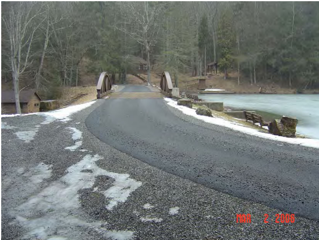
SENECA DAM MODIFICATION, POCAHONTAS CO., WV
