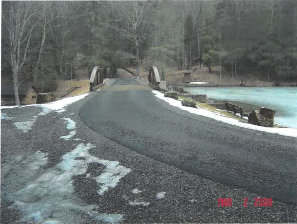
SENECA DAM MODIFICATION, POCAHONTAS CO., WV
