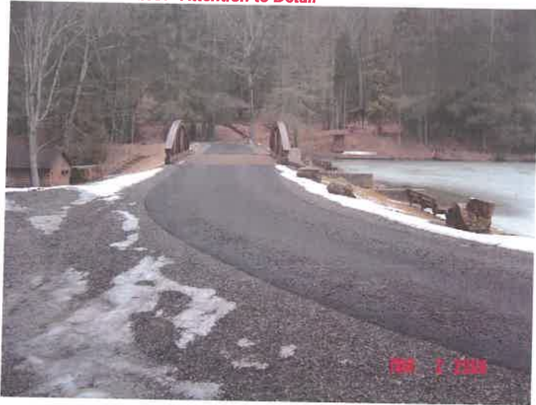
SENECA DAM MODIFICATION, POCAHONTAS CO., WV
