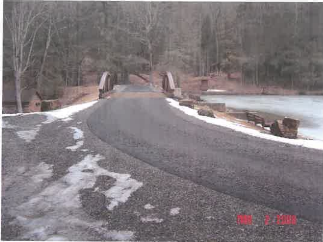
SENECA DAM MODIFICATION, POCAHONTAS CO., WV
