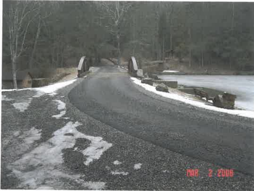
SENECA DAM MODIFICATION, POCAHONTAS CO., WV
