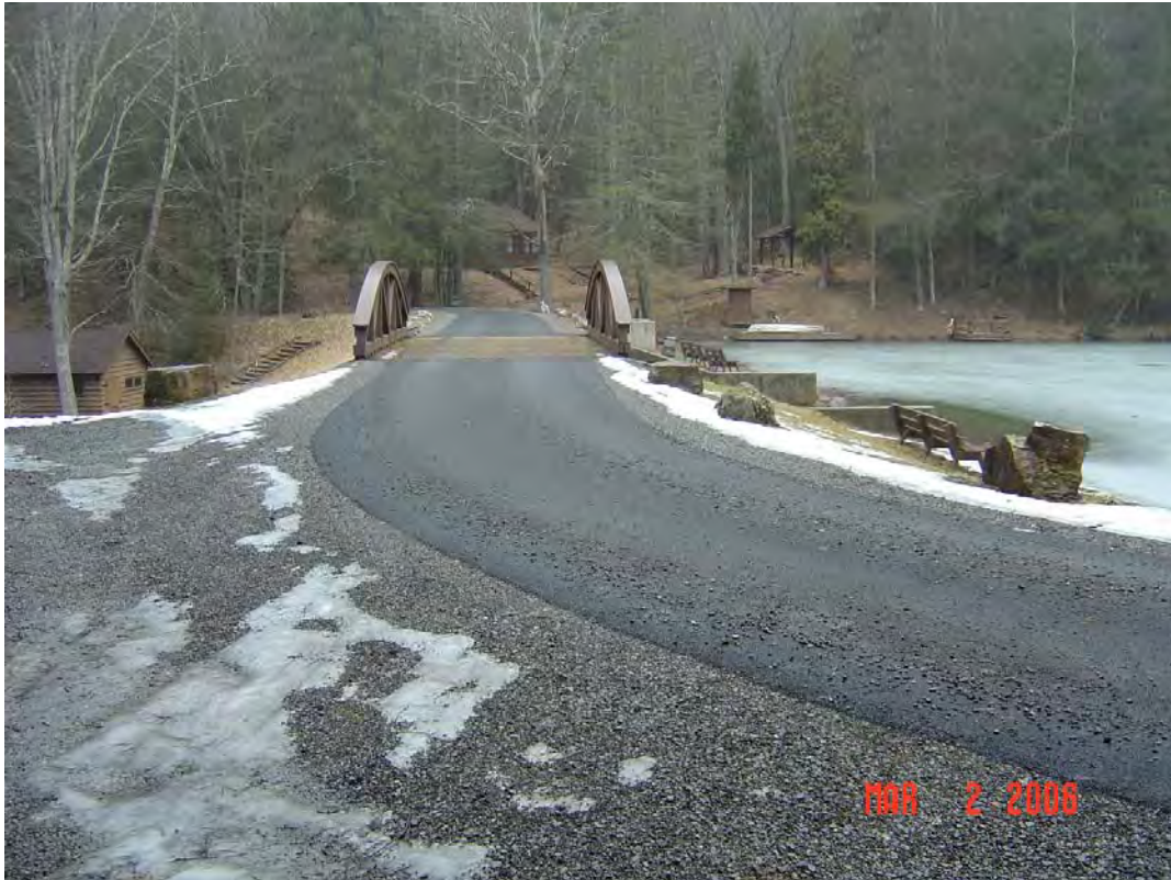
SENECA DAM MODIFICATION, POCAHONTAS CO., WV
