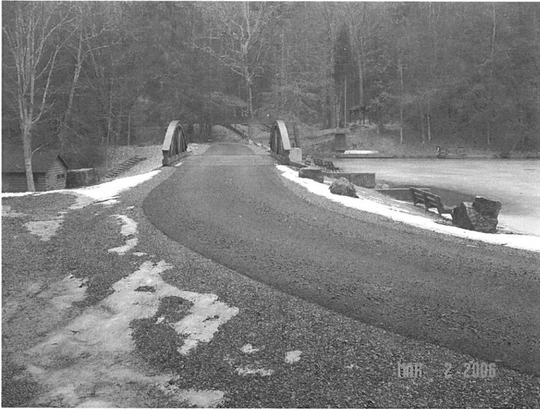
SENECA DAM MODIFICATION, POCAHONTAS CO., WV
