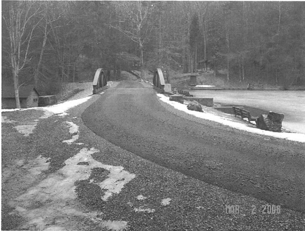
SENECA DAM MODIFICATION, POCAHONTAS CO., WV
