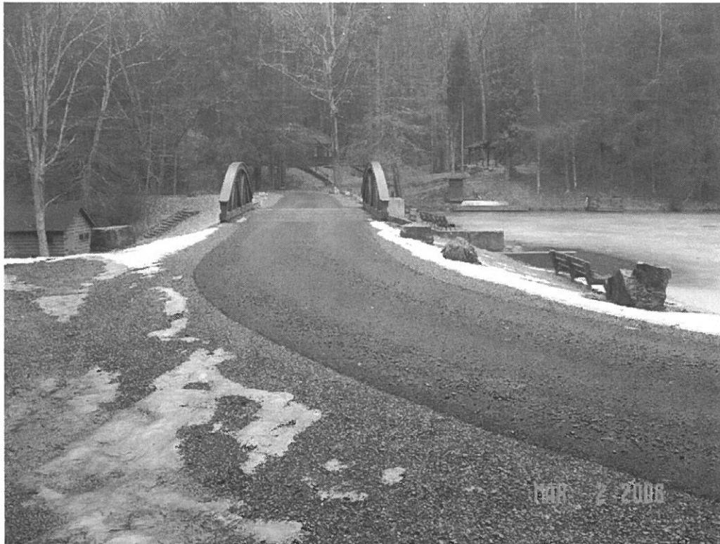
SENECA DAM MODIFICATION, POCAHONTAS CO., WV
