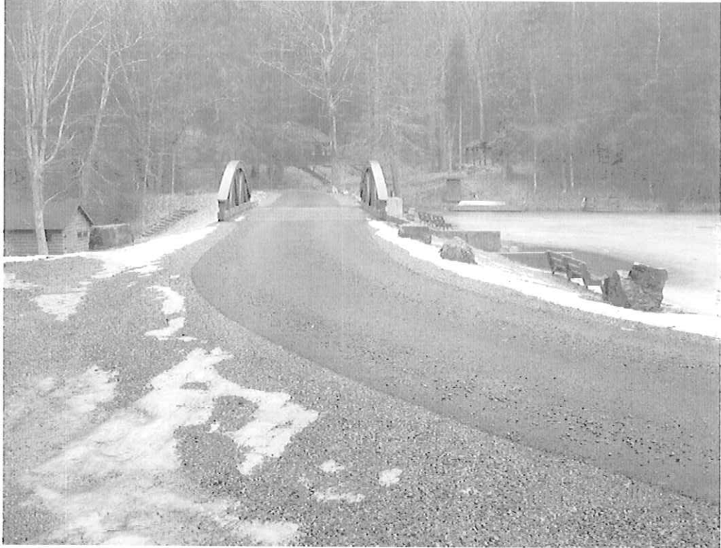
SENECA DAM MODIFICATION, POCAHONTAS CO., WV
