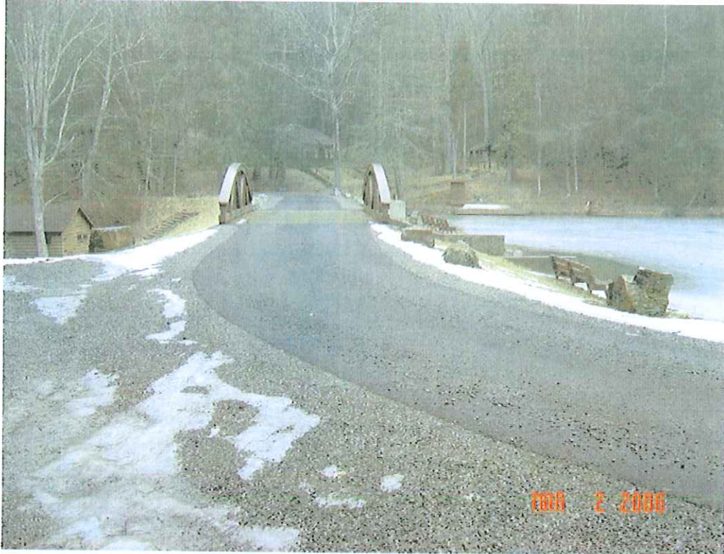
SENECA DAM MODIFICATION, POCAHONTAS CO., WV
