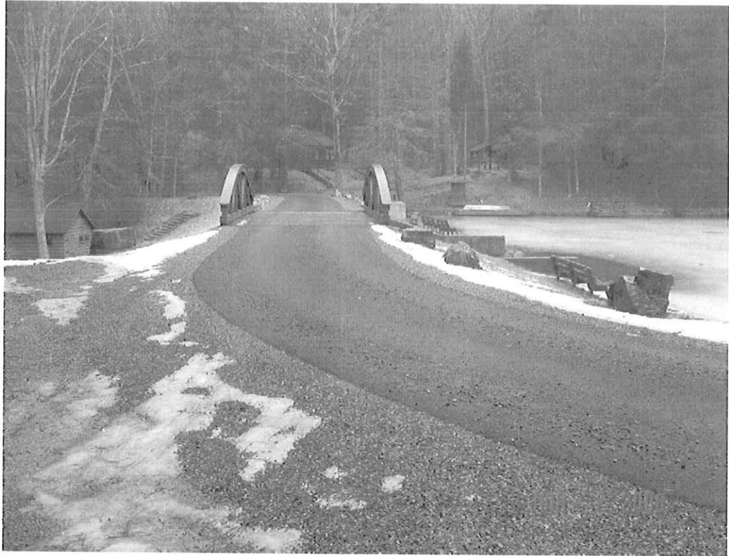
SENECA DAM MODIFICATION, POCAHONTAS CO., WV
