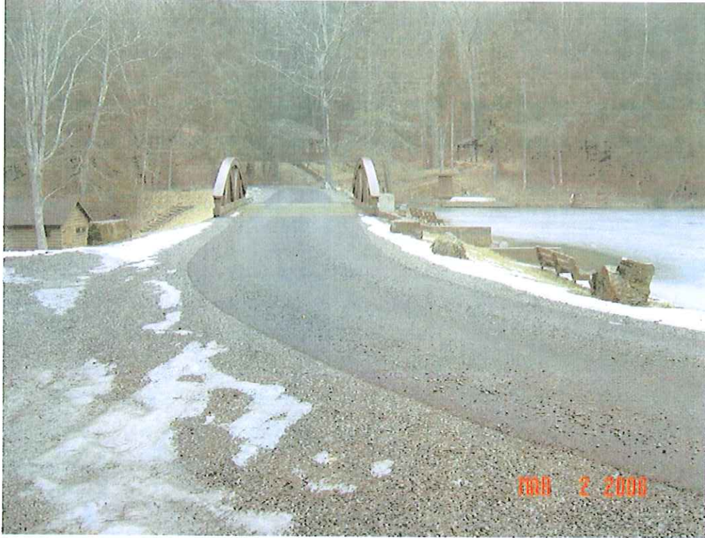
SENECA DAM MODIFICATION, POCAHONTAS CO., WV
