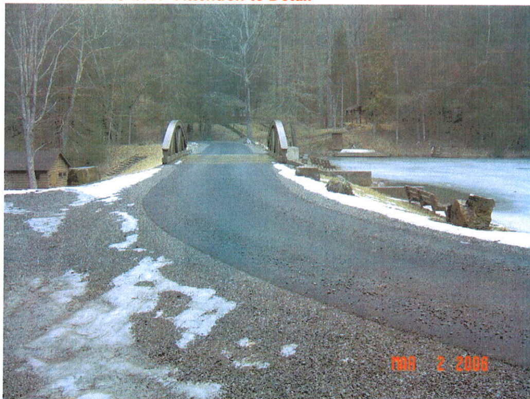
SENECA DAM MODIFICATION, POCAHONTAS CO., WV
