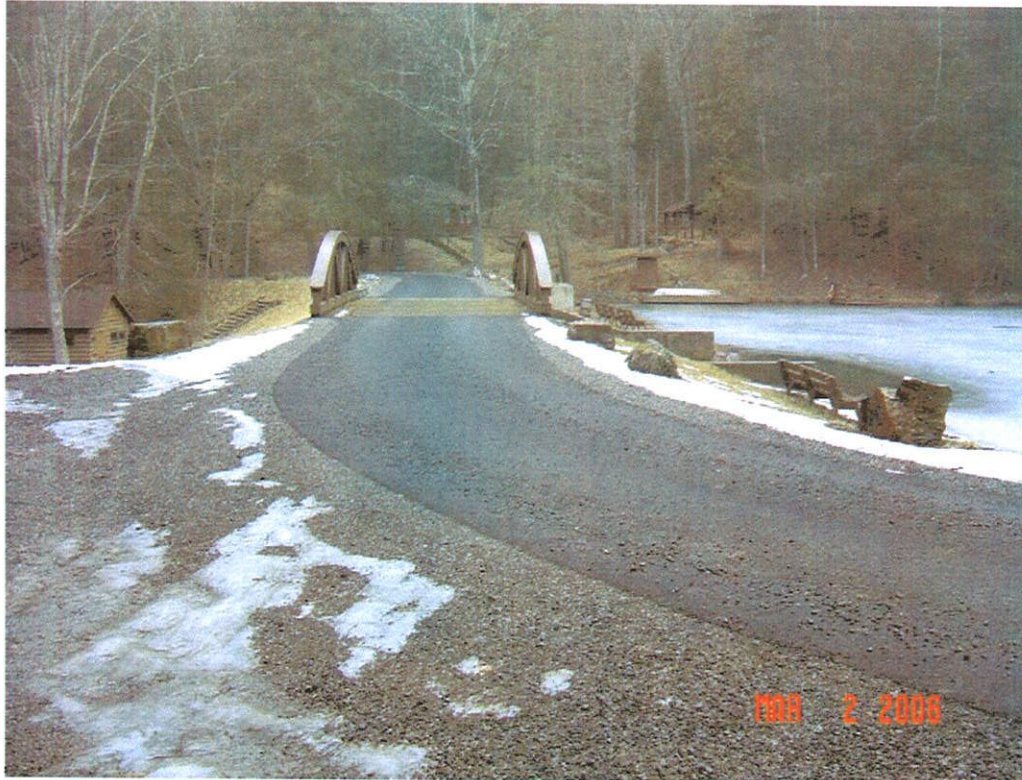
SENECA DAM MODIFICATION, POCAHONTAS CO., WV
