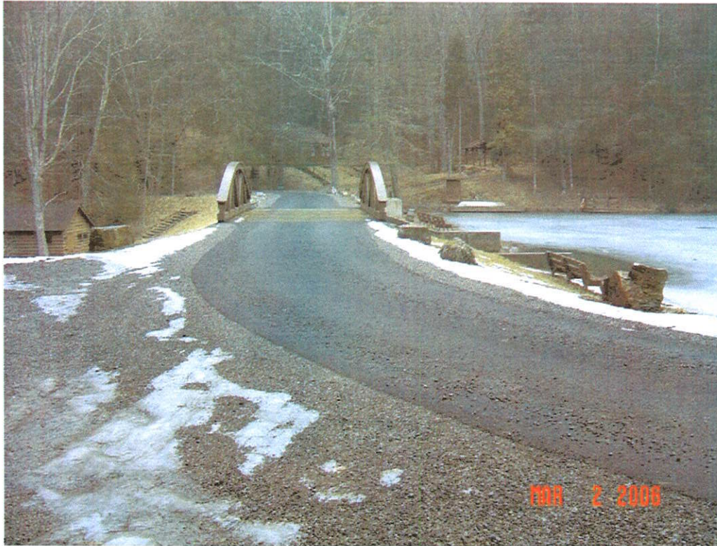
SENECA DAM MODIFICATION, POCAHONTAS CO., WV
