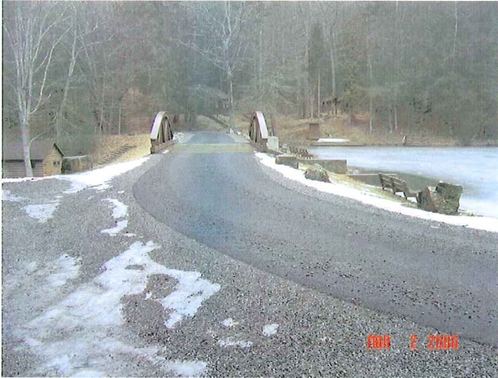
SENECA DAM MODIFICATION, POCAHONTAS CO., WV
