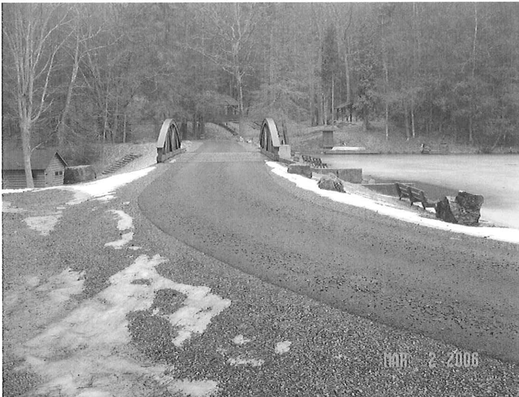
SENECA DAM MODIFICATION, POCAHONTAS CO., WV
