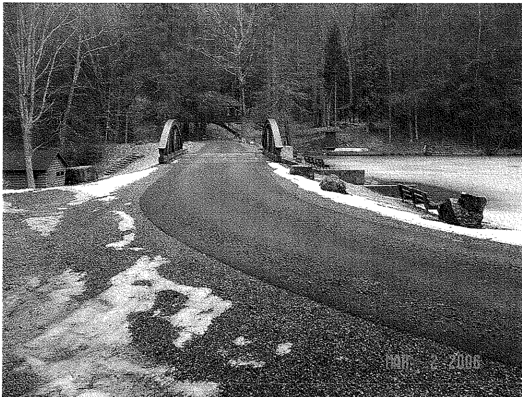
SENECA DAM MODIFICATION, POCAHONTAS CO., WV
