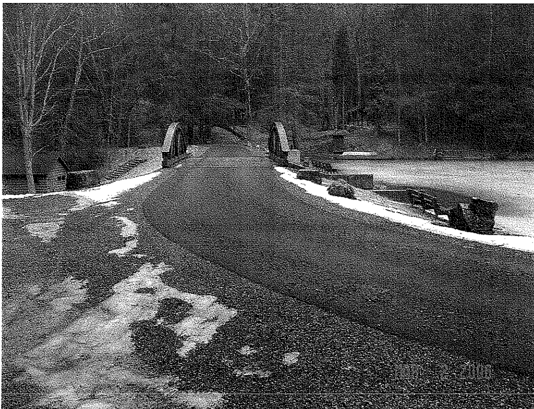
SENECA DAM MODIFICATION, POCAHONTAS CO., WV
