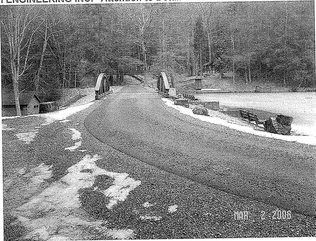
SENECA DAM MODIFICATION, POCAHONTAS CO., WV
