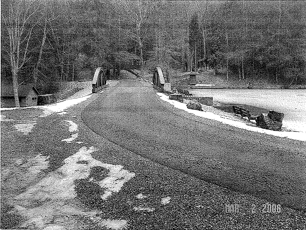
SENECA DAM MODIFICATION, POCAHONTAS CO., WV
