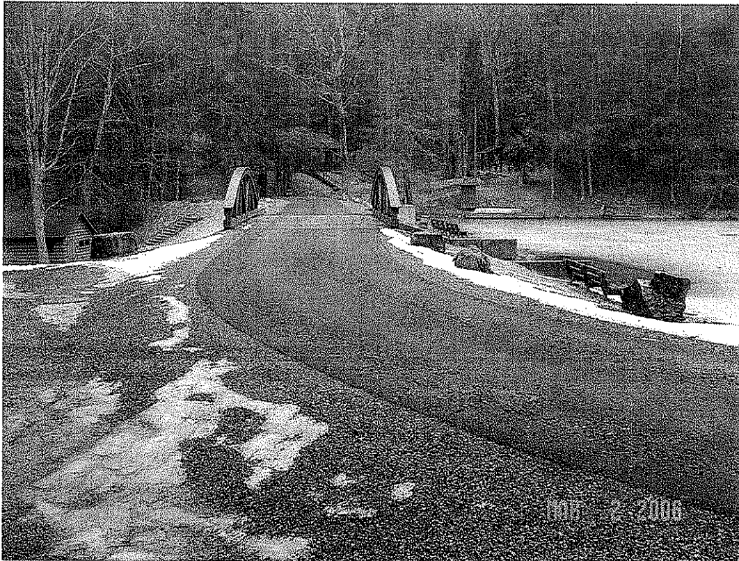
SENECA DAM MODIFICATION, POCAHONTAS CO., WV
