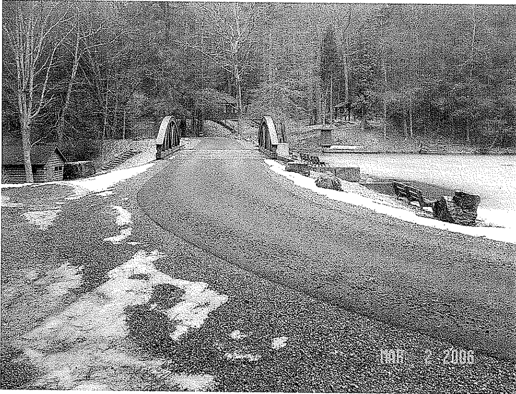
SENECA DAM MODIFICATION, POCAHONTAS CO., WV
