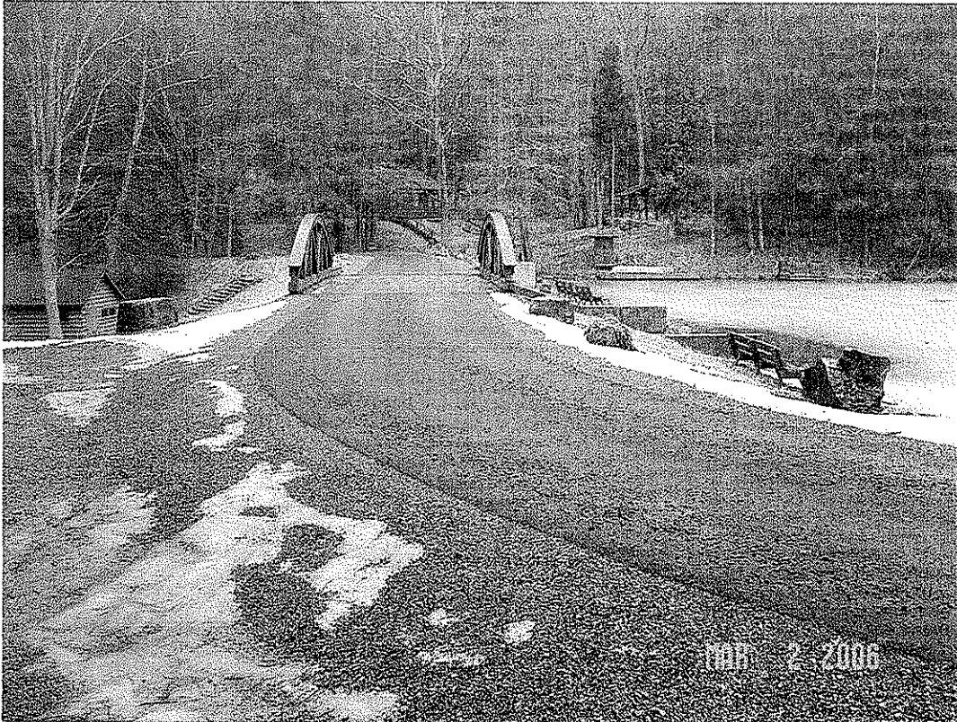
SENECA DAM MODIFICATION, POCAHONTAS CO., WV
