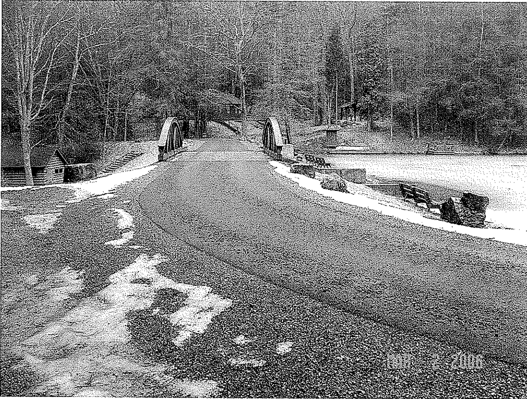
SENECA DAM MODIFICATION, POCAHONTAS CO., WV
