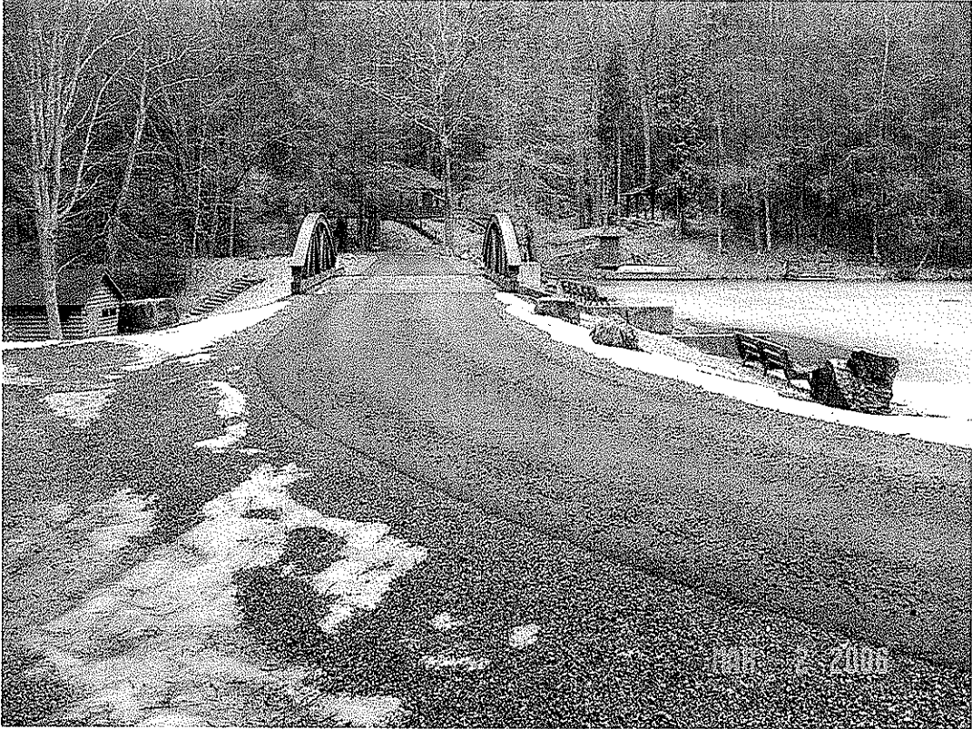
SENECA DAM MODIFICATION, POCAHONTAS CO., WV
