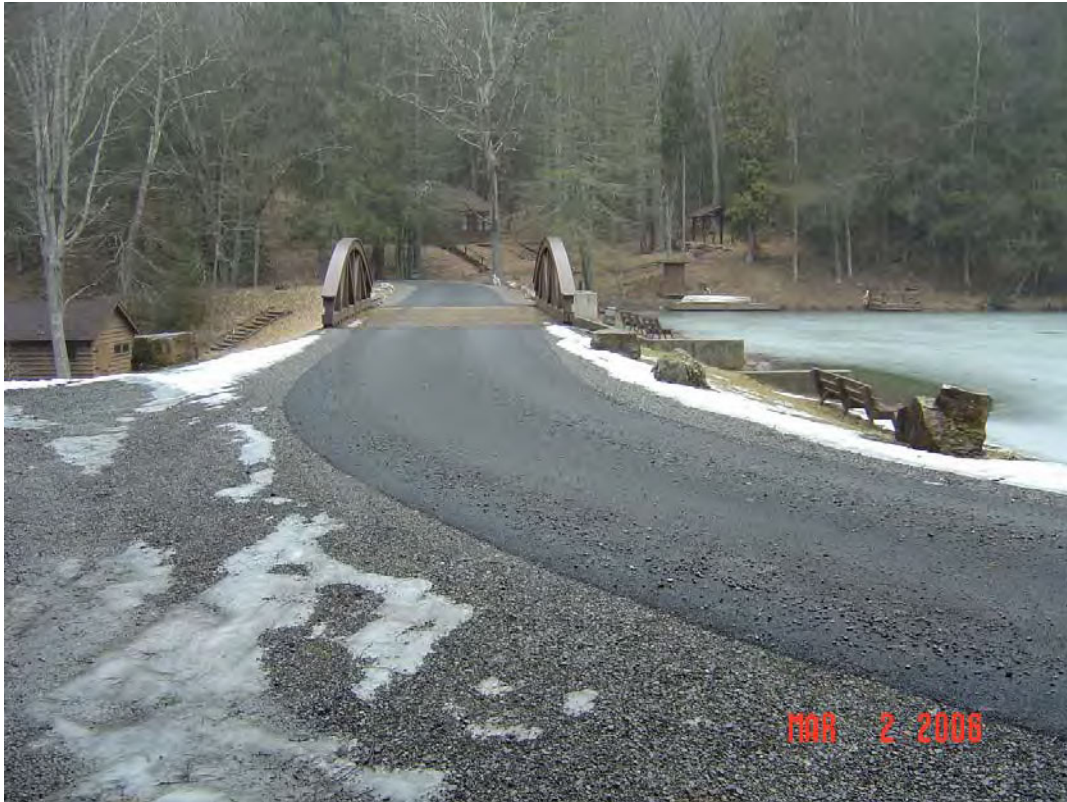
SENECA DAM MODIFICATION, POCAHONTAS CO., WV
