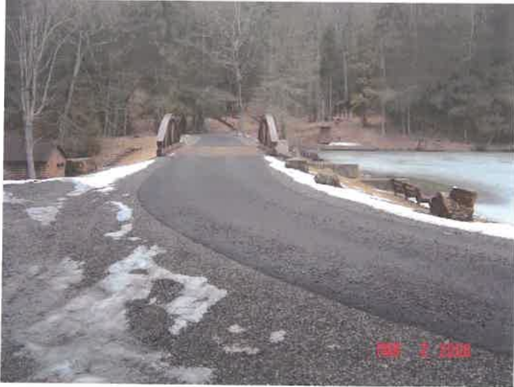
SENECA DAM MODIFICATION, POCAHONTAS CO., WV
