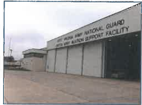
AASF #2 Existing Hangar
