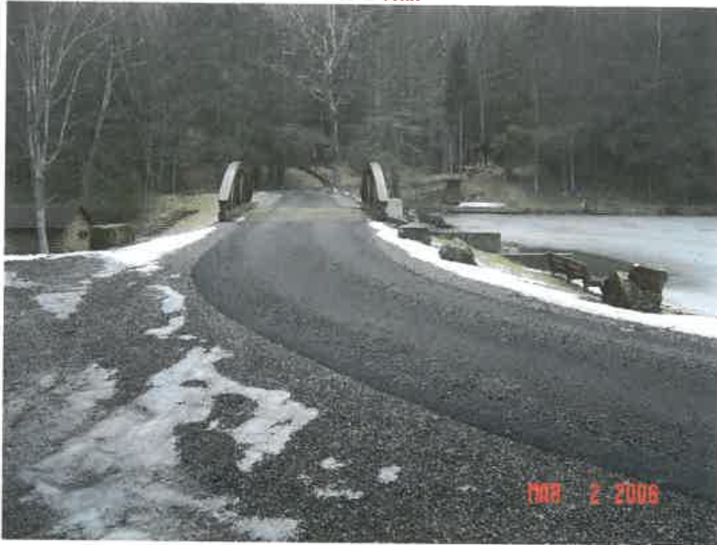
SENECA DAM MODIFICATION, POCAHONTAS CO., WV
