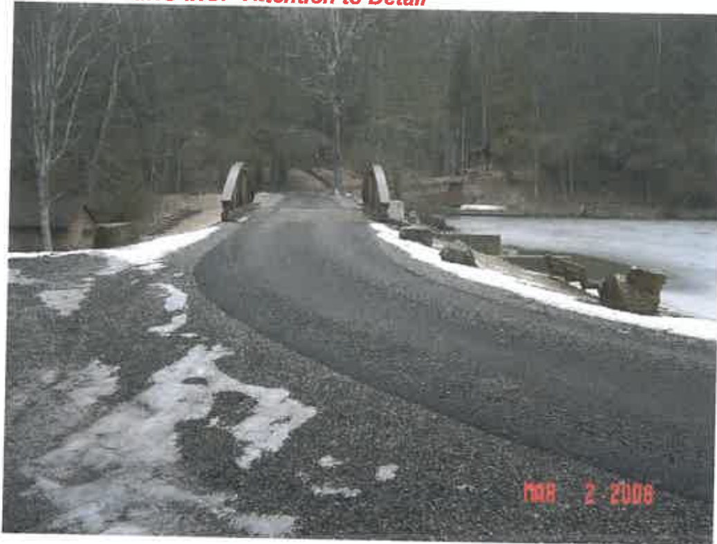
SENECA DAM MODIFICATION, POCAHONTAS CO., WV
