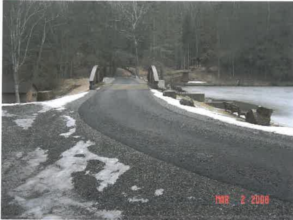
SENECA DAM MODIFICATION, POCAHONTAS CO., WV
