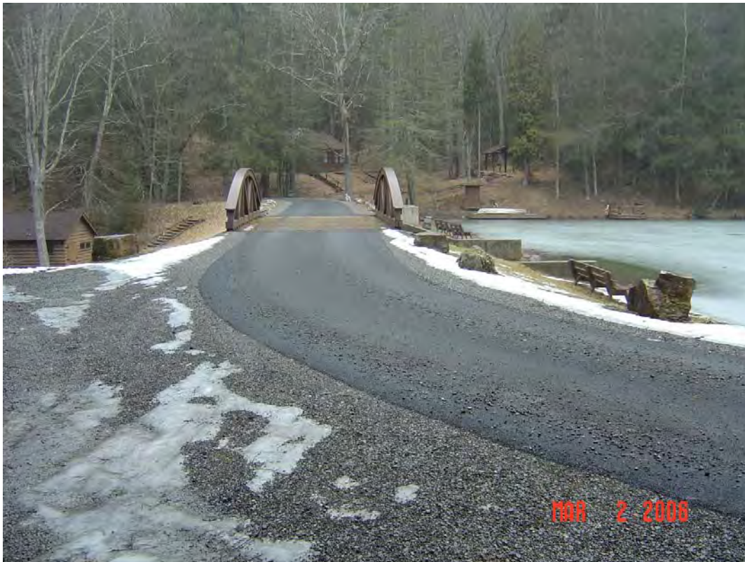
SENECA DAM MODIFICATION, POCAHONTAS CO., WV
