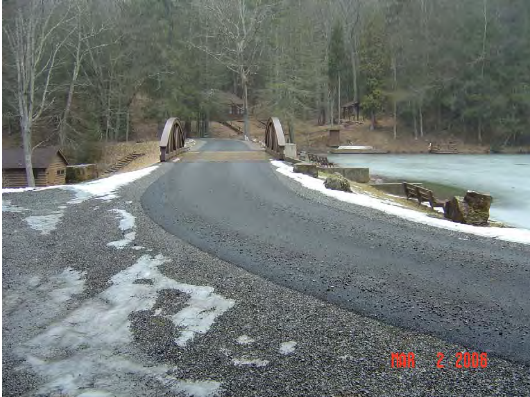
SENECA DAM MODIFICATION, POCAHONTAS CO., WV
