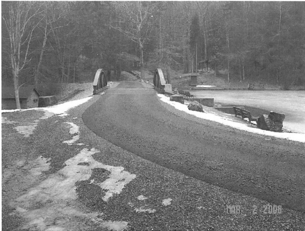
SENECA DAM MODIFICATION, POCAHONTAS CO., WV
