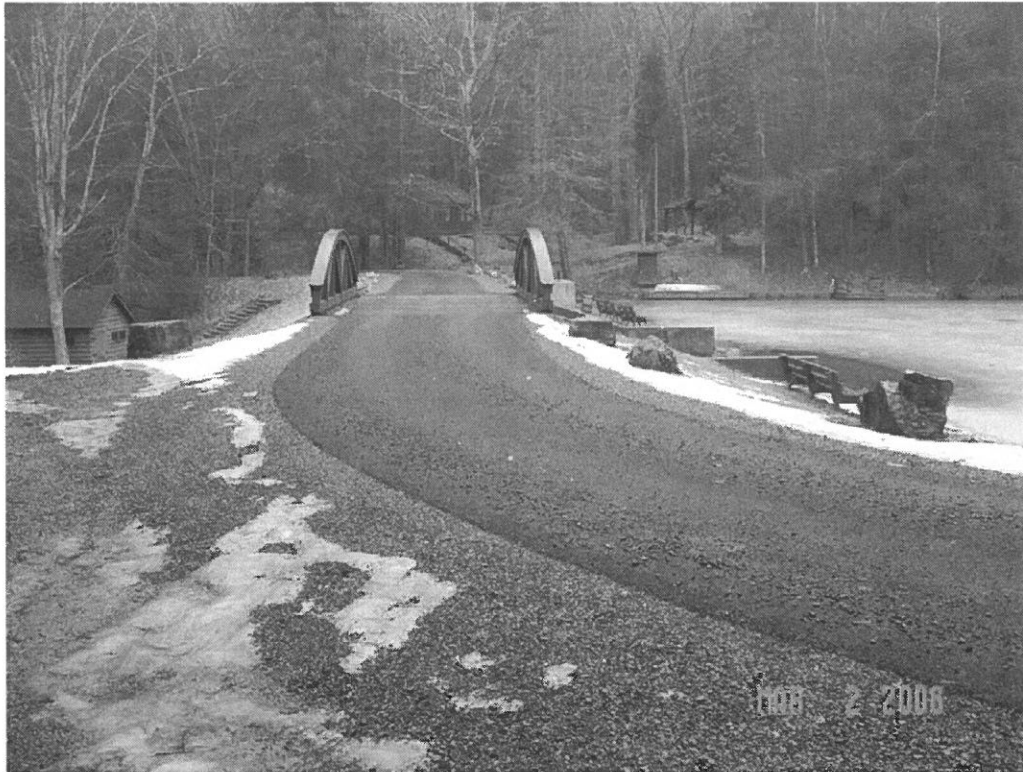
SENECA DAM MODIFICATION, POCAHONTAS CO., WV
