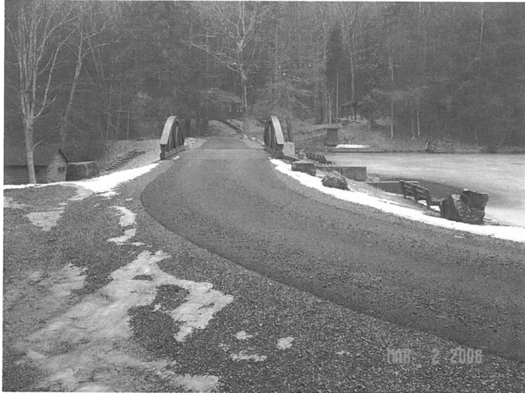
SENECA DAM MODIFICATION, POCAHONTAS CO., WV
