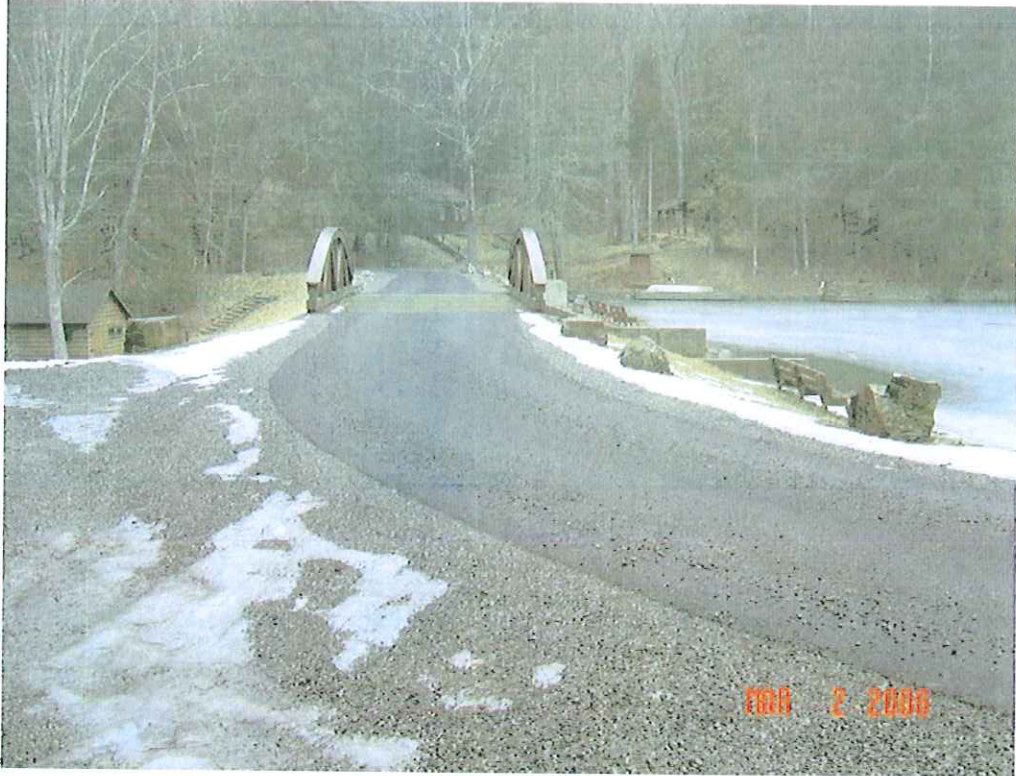
SENECA DAM MODIFICATION, POCAHONTAS CO., WV
