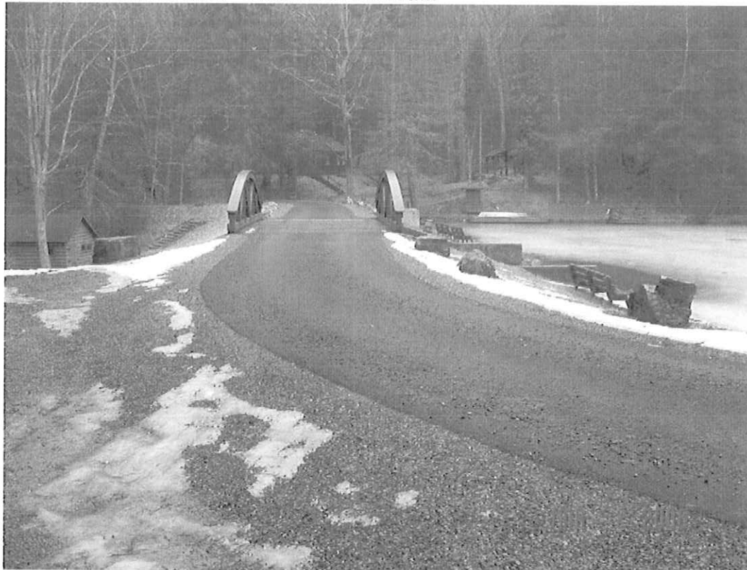
SENECA DAM MODIFICATION, POCAHONTAS CO., WV
