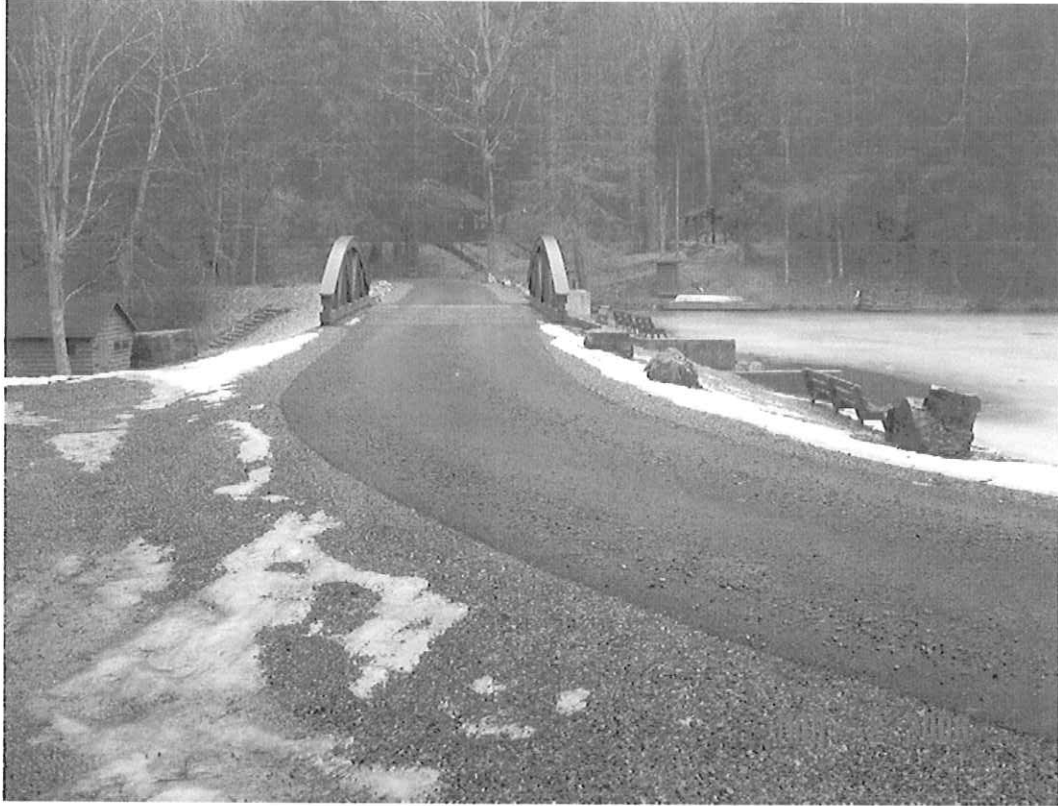
SENECA DAM MODIFICATION, POCAHONTAS CO., WV
