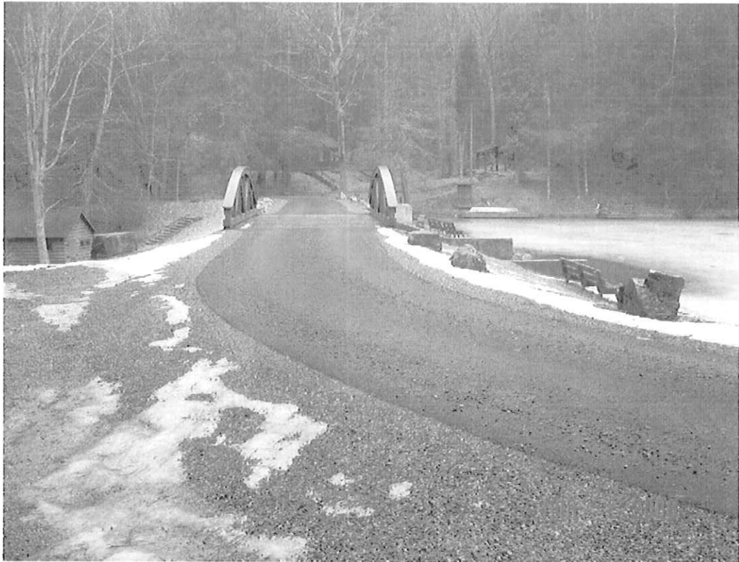
SENECA DAM MODIFICATION, POCAHONTAS CO., WV
