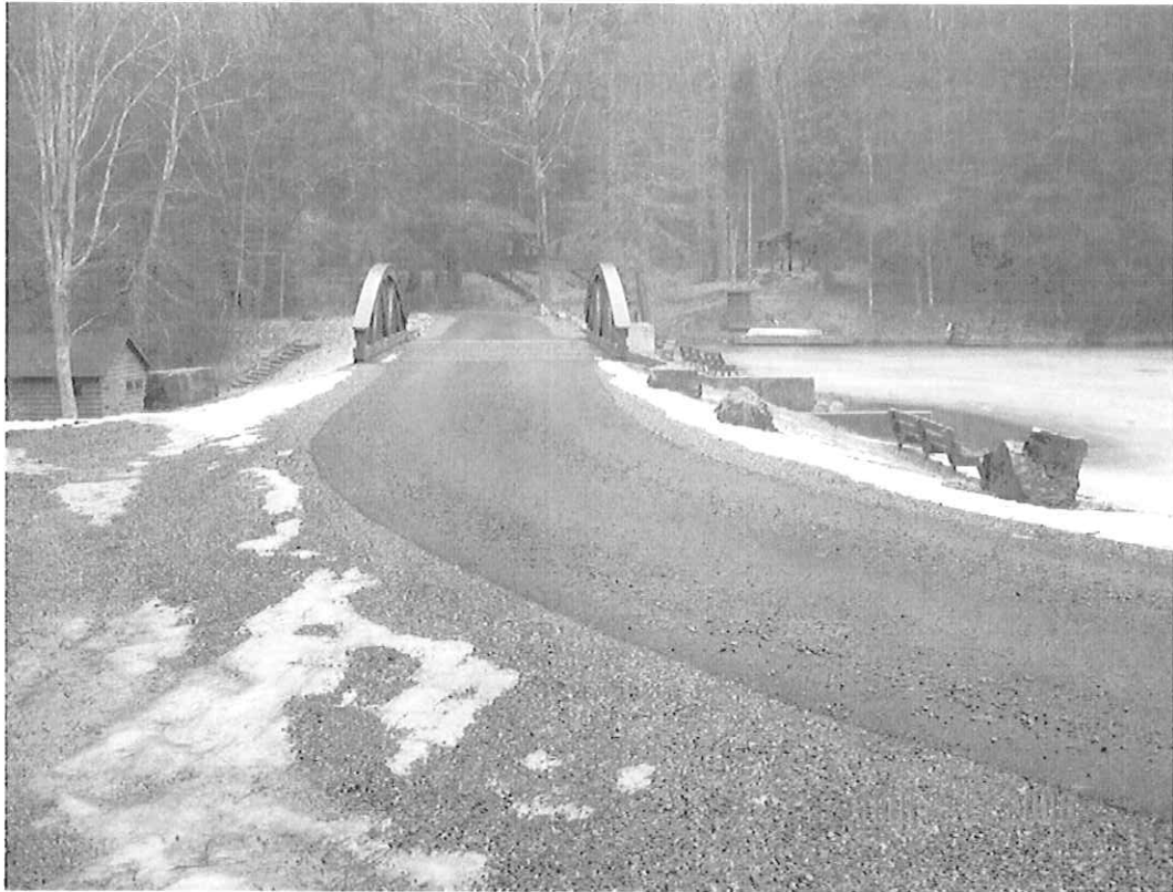
SENECA DAM MODIFICATION, POCAHONTAS CO., WV
