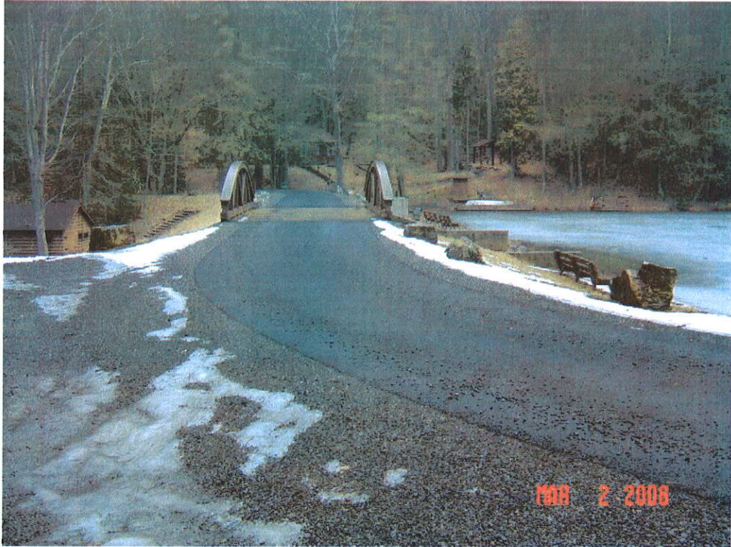
SENECA DAM MODIFICATION, POCAHONTAS CO., WV
