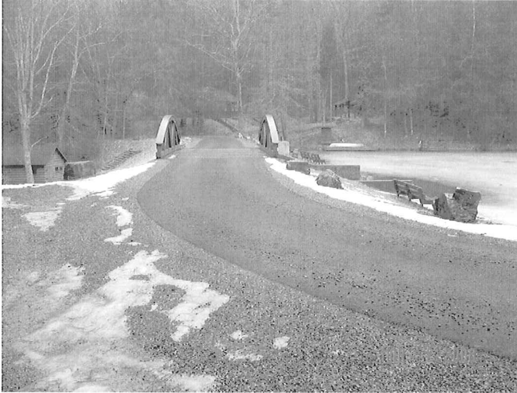
SENECA DAM MODIFICATION, POCAHONTAS CO., WV
