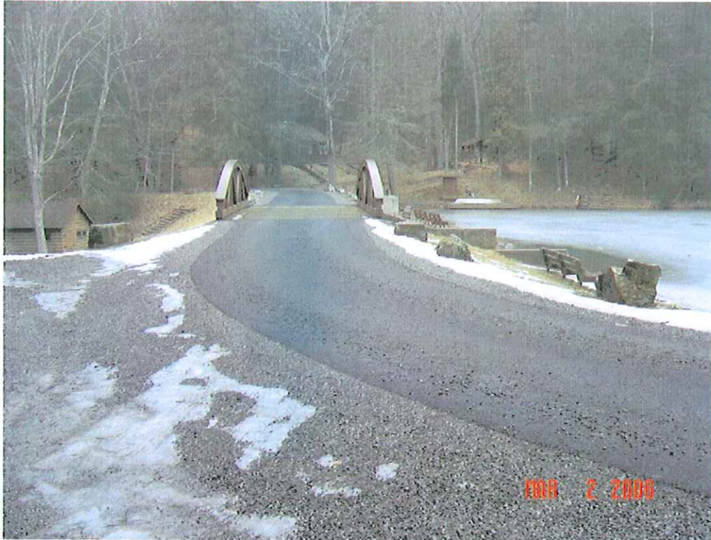
SENECA DAM MODIFICATION, POCAHONTAS CO., WV
