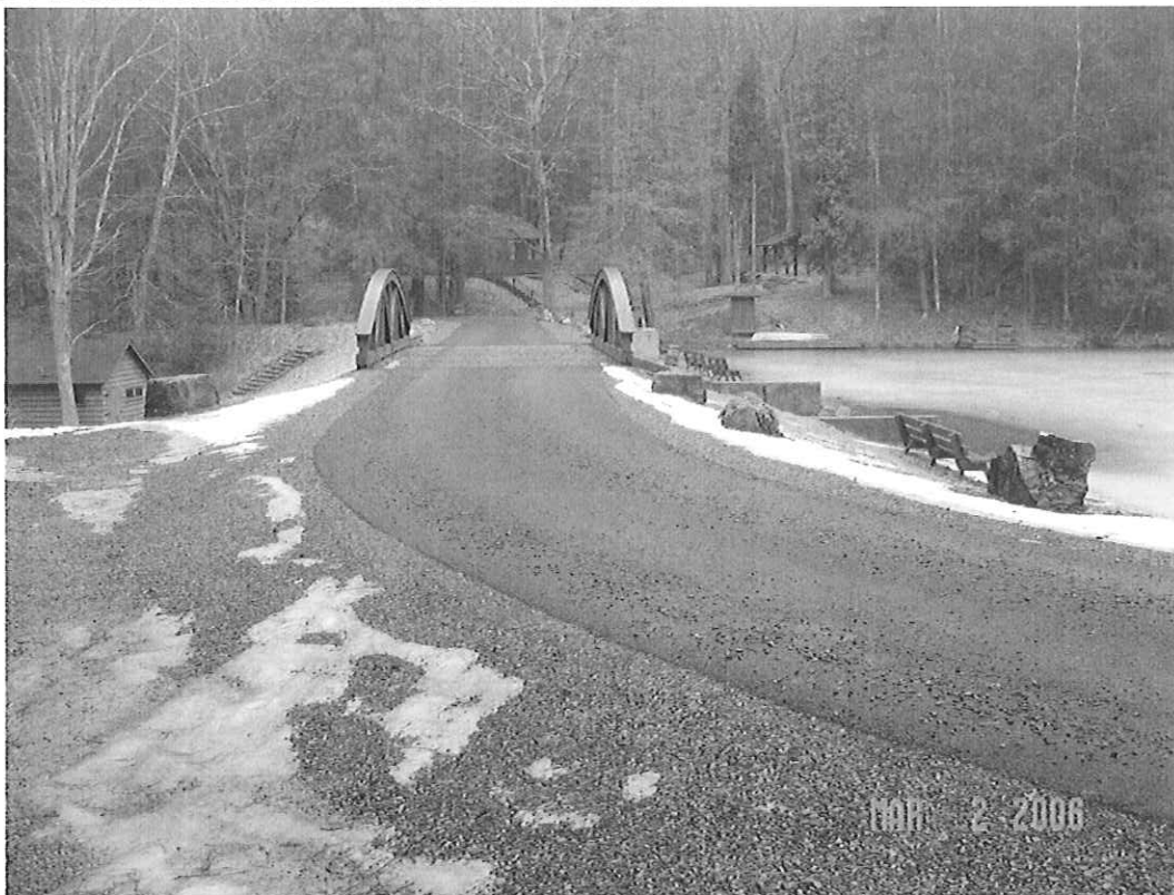
SENECA DAM MODIFICATION, POCAHONTAS CO., WV
