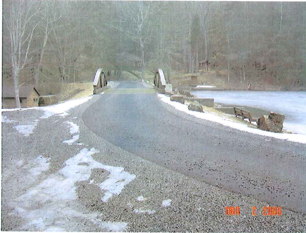
SENECA DAM MODIFICATION, POCAHONTAS CO., WV
